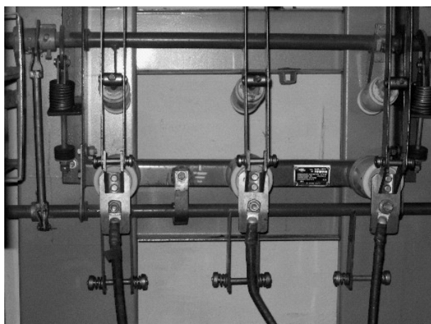
Рисунок 2 – Фотография и термограмма (негатив) дефекта контактного соединения в ячейке РТП-1
