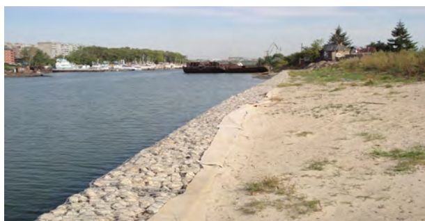
Рисунок 3 – Укрепление берега габионами в районе Затона
