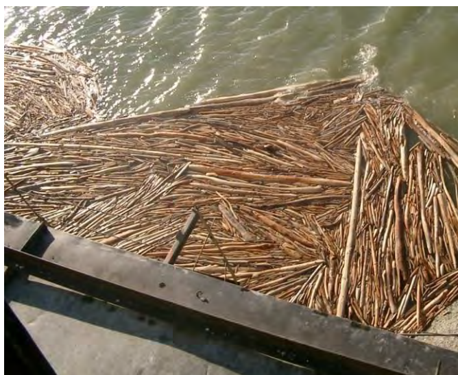
Рисунок 10 – Скопление плавающей древесины у здания ГЭС
