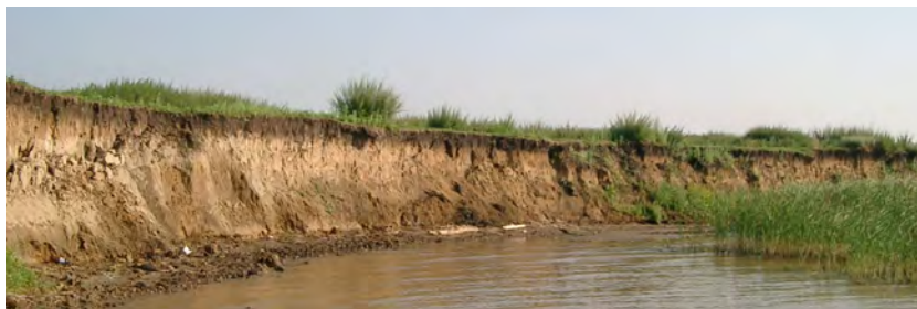
Рисунок 1 – Форма разрушения берега в виде отколов небольших масс супесчаного грунта по вертикальным трещинам
