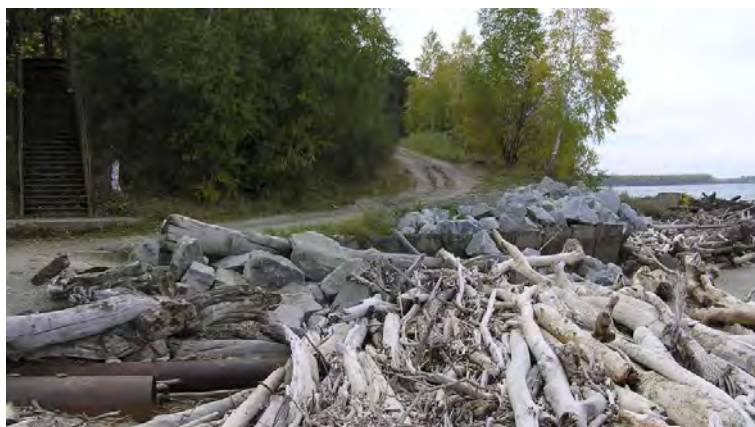
Рисунок 8 – Фрагмент крепления берега каменной наброской
