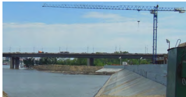
Рисунок 4 – Берегоукрепление в районе Аквапарка
