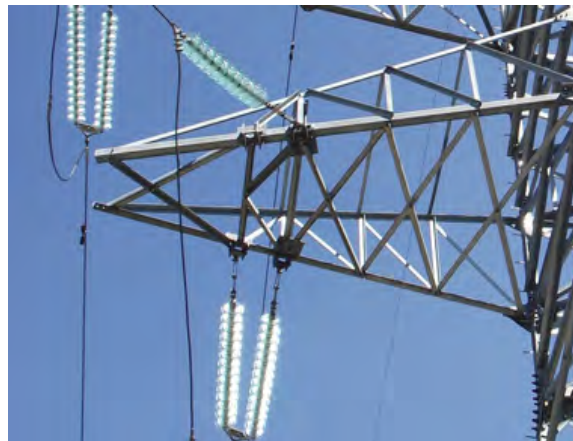
Рисунок 2 – Места подвески на примере линии электропередач
