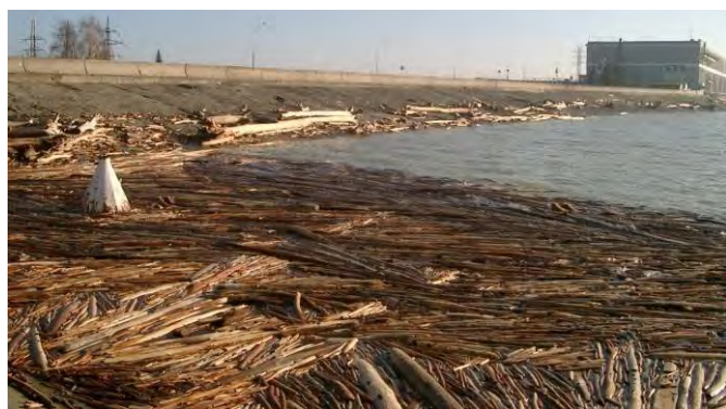
Рисунок 9 – Скопление леса в левобережной части плотины
