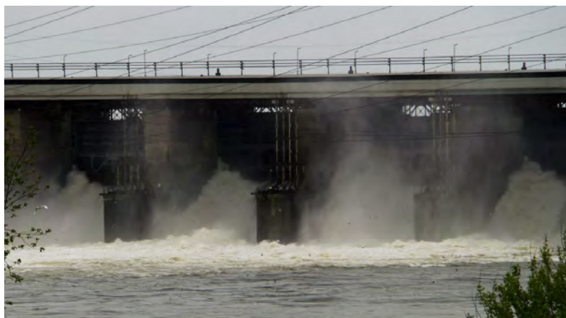
Рисунок 1 – Водосливная плотина Новосибирской ГЭС
