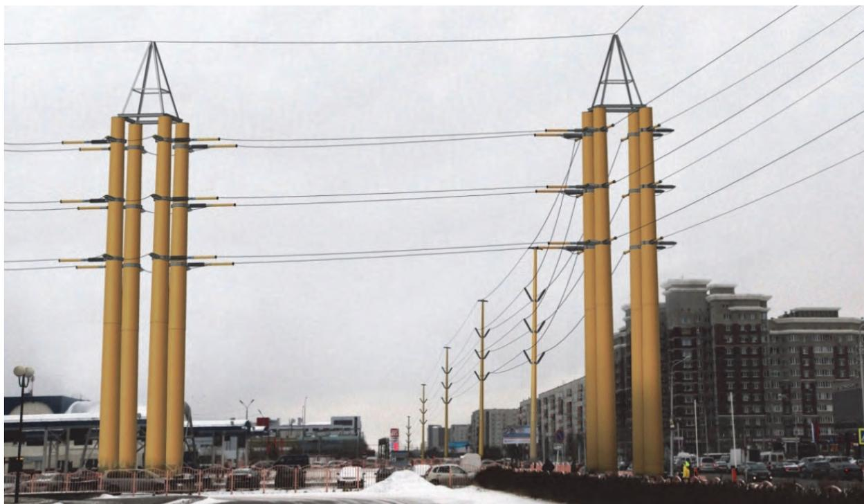
*Рисунок 2 – Вариант реконструируемой воздушной линии электропередачи на 110 кВ с мощными опорами из композитных материалов*
